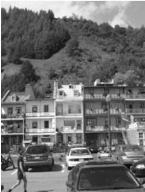
Québec, Cap-Diamant – Édifices adossés à une pente de 75 mètres de dénivelée. Versant raide (40° à 45°) partiellement boisé qui a produit de nombreuses avalanches mortelles.
